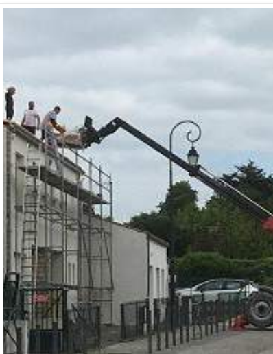
Réparation du toit de l'école de musique
