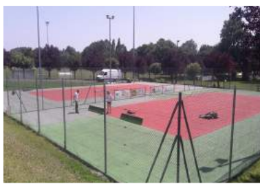
Réfection des courts de tennis
