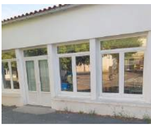
Remplacement des vitres abîmées de l'école élémentaire
