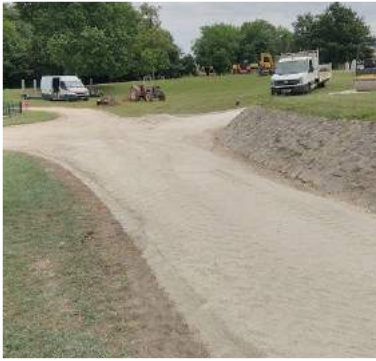
Réfection des allées du parc de loisirs
